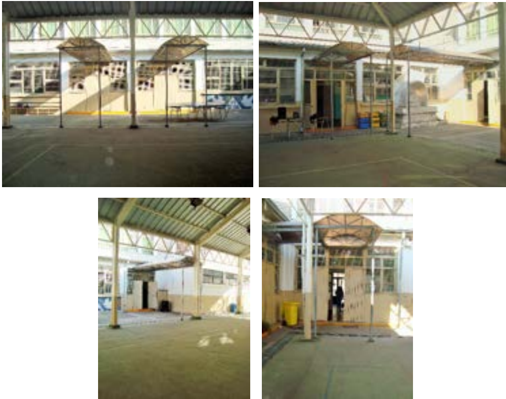
Construcción de accesos techados a patio cubierto central
