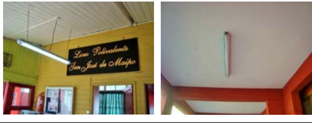
Instalación de luminarias LED en dependencias administrativa, salas de clase y pasillos
