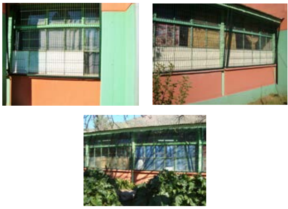
Instalación de protecciones en ventanas externas
