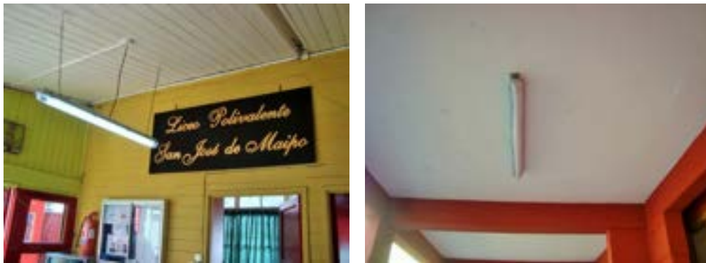
Instalación de luminarias LED en dependencias administrativa, salas de clase y pasillos
