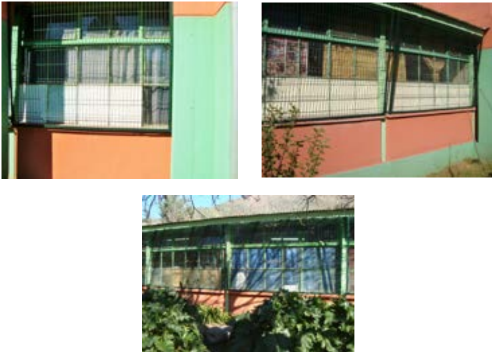
Instalación de protecciones en ventanas externas
