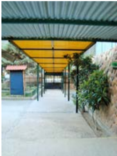
Construcción de acceso techado a escuela
