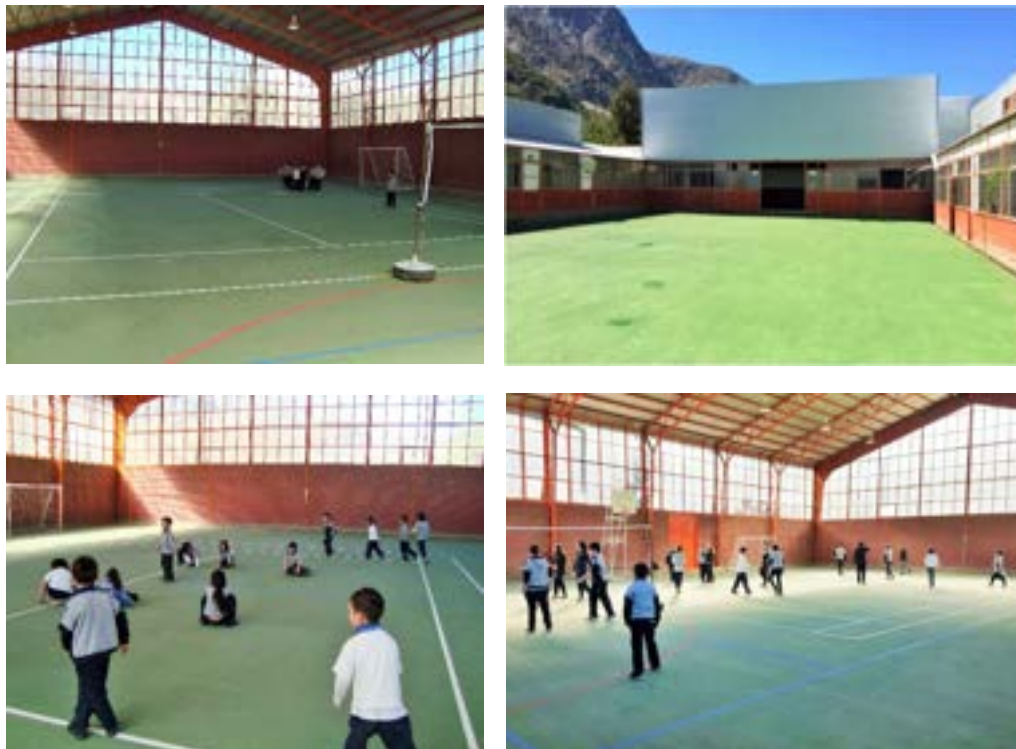
Remodelación gimnasio y patio central
