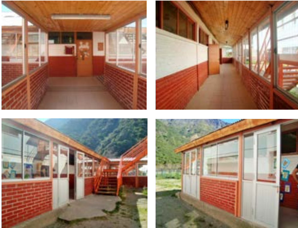
Cierre completo de pasillos de acceso a salas
